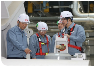
당진화력 9,10 호기 건설현장 방문
